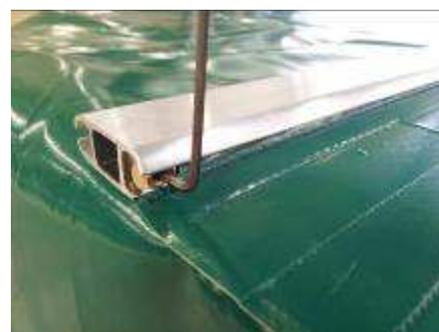
Une fois les profils reliés, fixer à une extrémité d'un profil un des 2 inserts simples à l'aide de la clé Allen puis faire la même manipulation à l'autre extrémité du profil.
